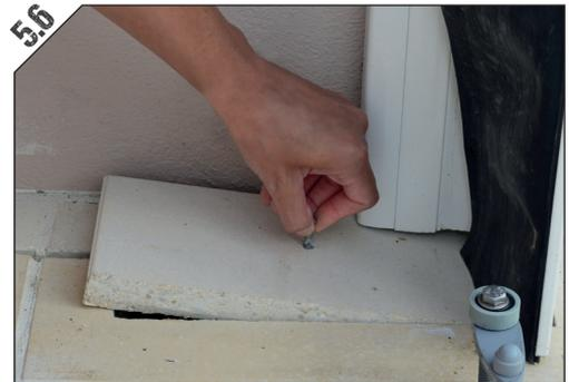
Coller le revêtement en s'ajustant au verso de la grille et en s'assurant que les perçages sont bien dans l'axe.
