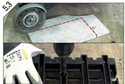
Présenter la grille sur un élément de revêtement et en délimiter le contour. Découper le revêtement pour l'ajuster à la bonne dimension. Percer un trou diamètre M8 dans l'axe du/des logement(s) d'écrous hexagonaux.
