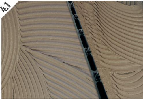
Les zones pleines de la face supérieure de la grille et les creux latéraux sont encollées à l'aide d'un mortier colle amélioré de classe C2 (selon la EN 12004), PRB Colflex, Weber colflex, Mapei keraflex ou équivalent\*.
