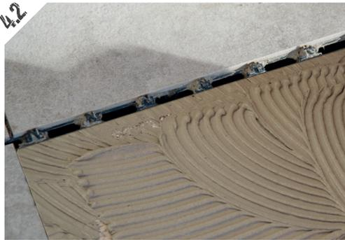
La partie du revêtement à cheval sur la dalle béton ou la chape est scellée de façon conventionnelle, à l'aide d'un mortier colle.
