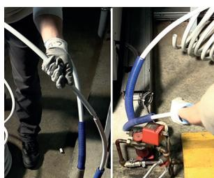
Pousser sur le nouveau tube, tout en tirant sur l'ancien (le tube endommagé est utilisé comme tire-fil).
