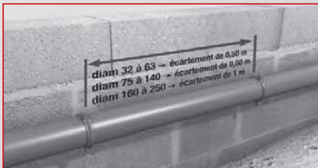
Canalisations d'allure horizontale
