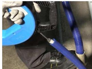
A l'aide du dérouleur, tirer sur le câble afin d'insérer le nouveau tube dans le fourreau.
