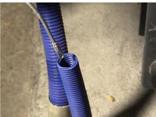
Passer l'aiguille du dérouleur dans le fourreau vide et la récupérer à l'autre extrémité du fourreau.
