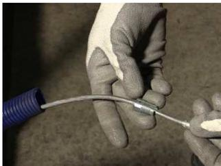
Connecter l'embout Ø16 à l'aiguille.
