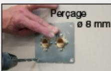
**6** Percer les quatre trous de fixation dans la cloison en veillant à ne pas percer les tubes.
