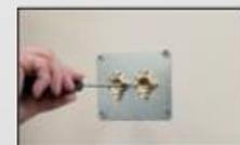
**8** Serrer de façon définitive les vis de fixation des coudes sur la platine.
