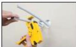
**2** Sortir les tubes FLUXO® par les trous et ajuster la longueur des tubes de façon à pouvoir positionner la pince.
