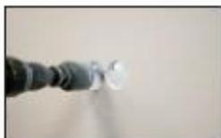
**1** Percer deux trous de 67 mm de diamètre dans la cloison de plâtre à l'aide d'une scie cloche (cf. gabarit).
