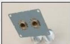
**4** Fixer les coudes d'encastrement sur la platine sans les serrer. Ne jamais plier les canalisations FLUXO®.
